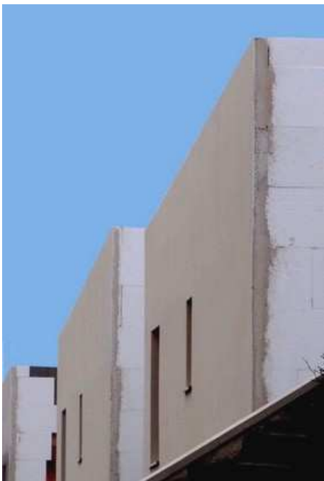
Un local industriel en construction? Non, des logements sociaux!
